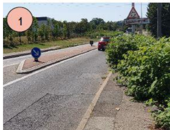
Absence de continuité des cheminements
